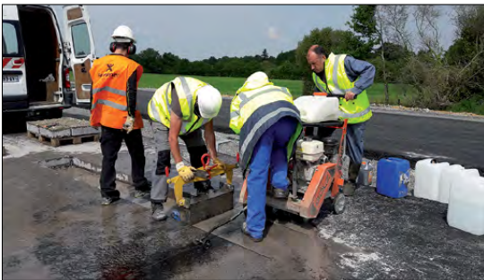
Figure 2.3 : Prélèvement des plaques d'enrobés de la GB Source : Université Gustave Eiffel
