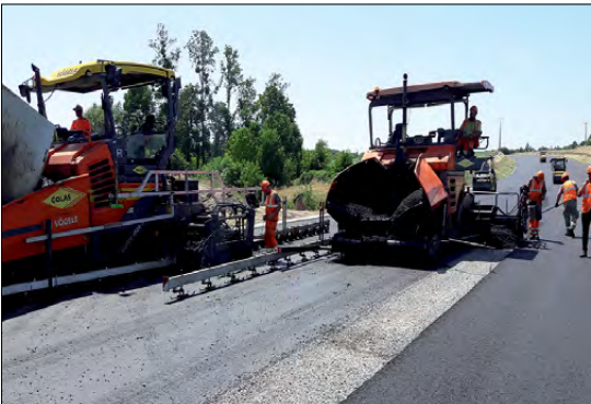
Figure 2.2 : Mise en œuvre de la couche de liaison en BBME Source : Université Gustave Eiffel
