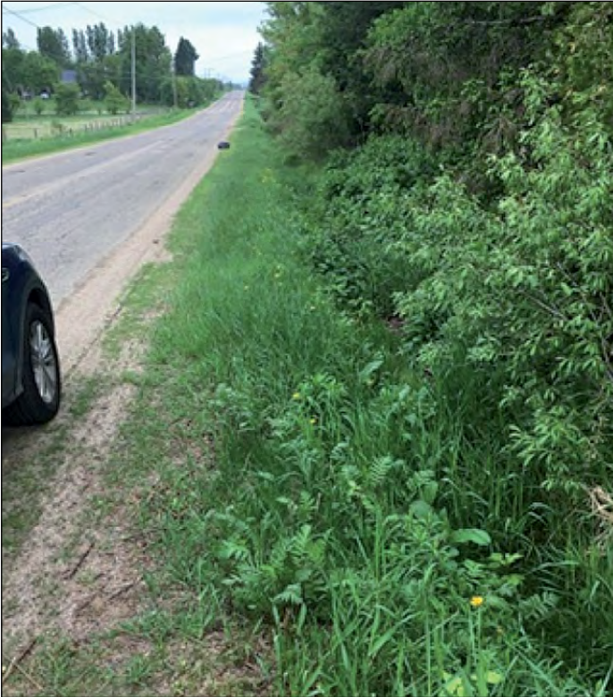
Figure 6 a) : Exemple de cas où le nettoyage des fossés serait nécessaire
