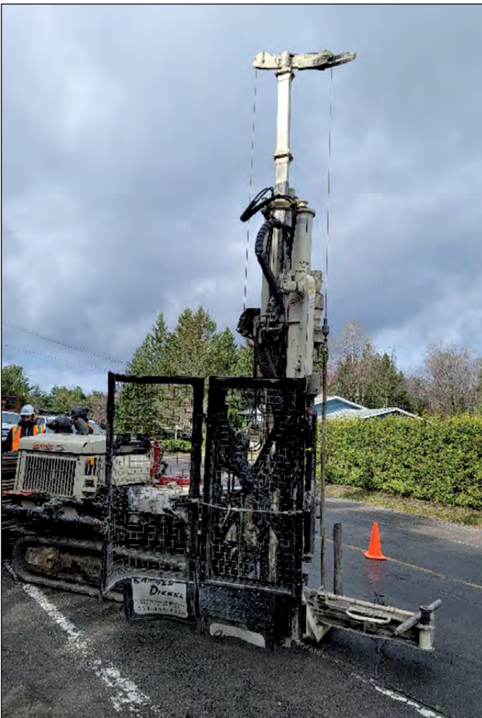
Figure 4 : Réalisation d'une campagne de caractérisation de la stratigraphie d'une chaussée existante par forage
