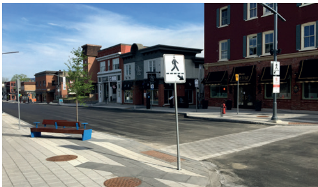
Rue Principale, Magog | Crédit : Ville de Magog
