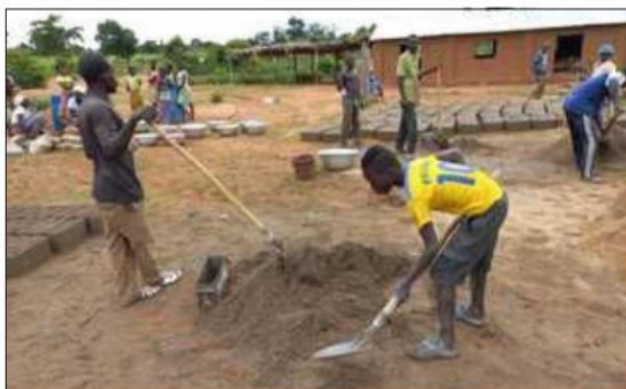
La construction du collège par des habitants bénévoles.
