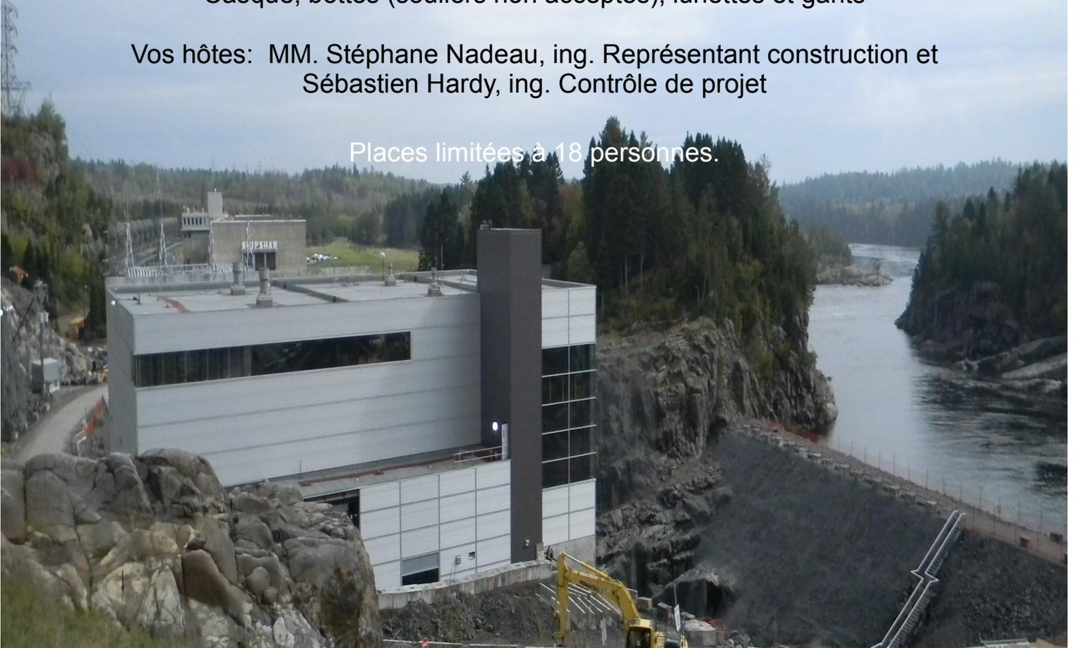
Le projet d'optimisation de la Centrale Shipshaw consiste en l'ajout d'une unité (#13) qui produira 225 MW avec un débit de 390 m<sup>3</sup>/seconde et une tête de 63,75 mètres.
